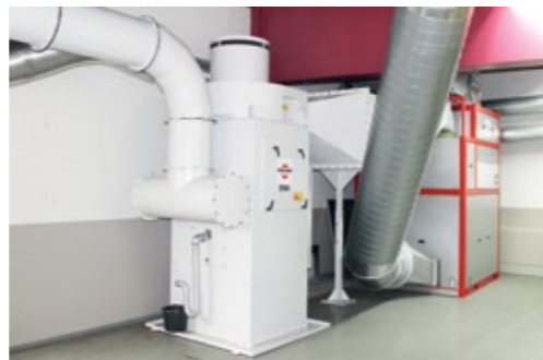
Das Konzept kombiniert den leistungsstarken Emulsionsnebelabscheider ENA mit ProTERM, dem thermischen Energie-Rückgewinnungs-Modul zur Wärmerückgewinnung
