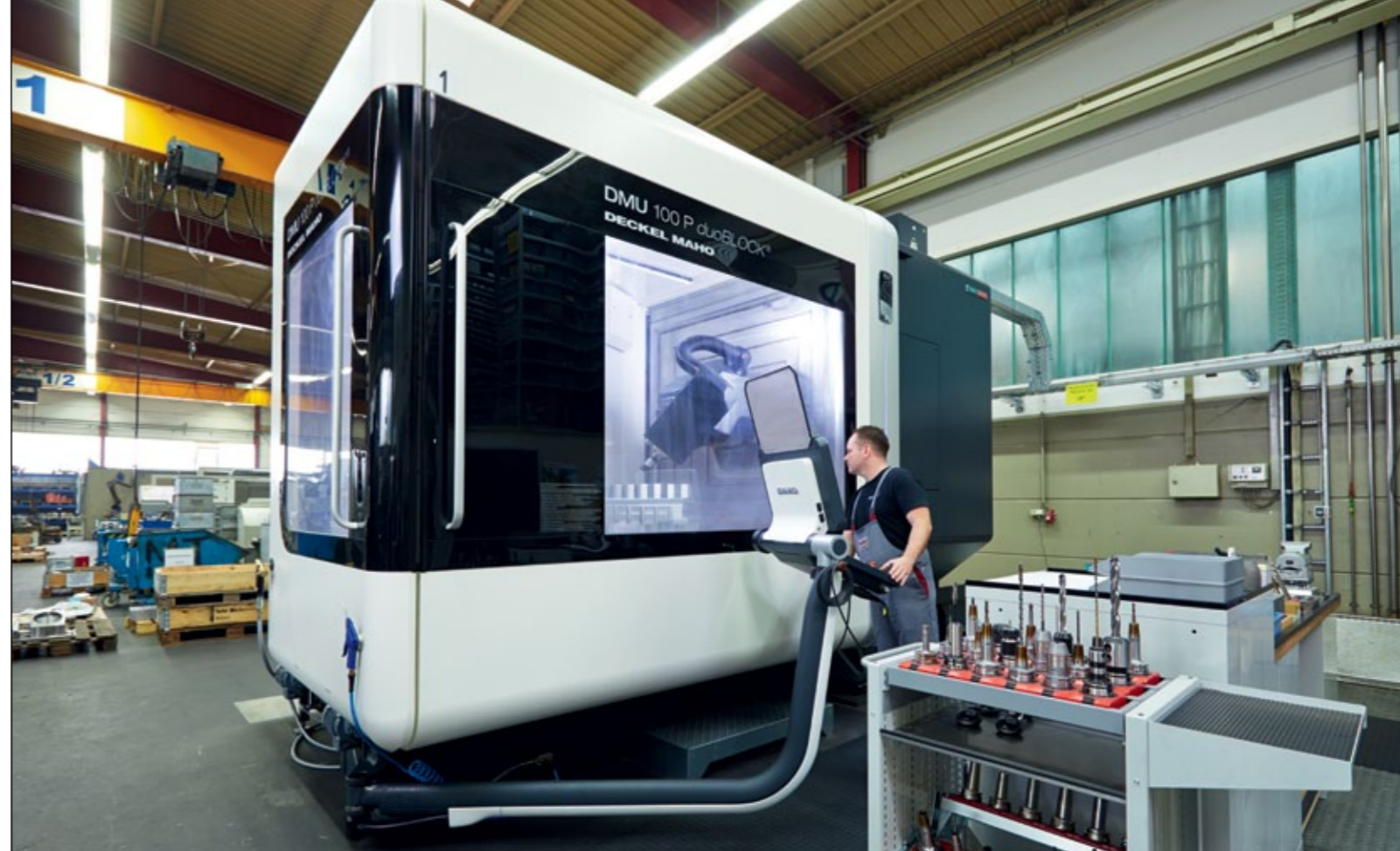
Für insgesamt elf Bearbeitungsmaschinen galt es eine effiziente und energetisch optimale Absauglösung zu finden, die zur Energieeffizienz-Philosophie der fischer Maschinentechnik-GmbH passt
